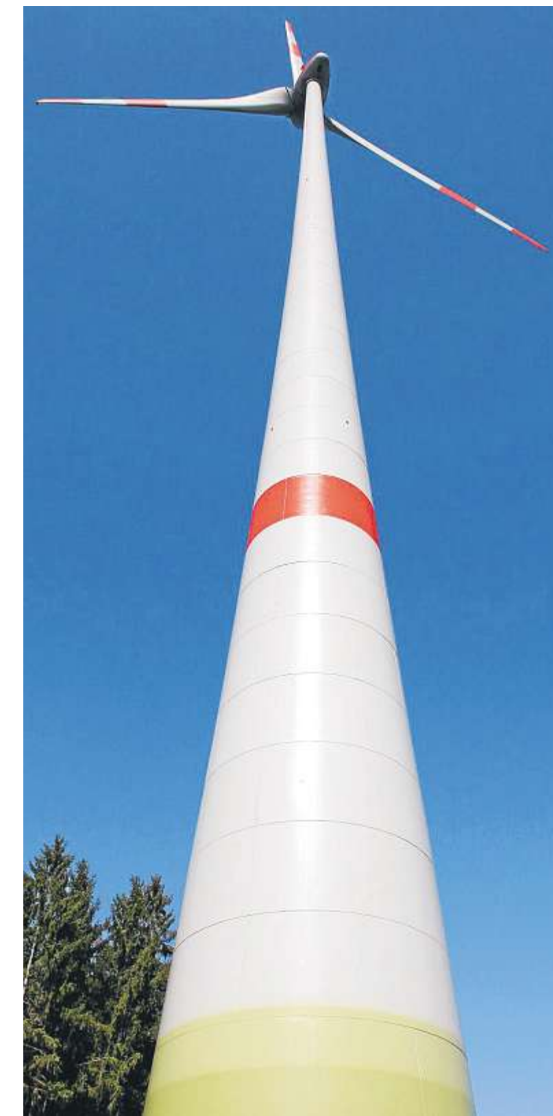
Hohe Effektivität und Erträge: Der Waldwindpark Fasanerie von Ostwind und Rewag nahe Hof wird kommende Woche offiziell eröffnet. Foto: Grabe
